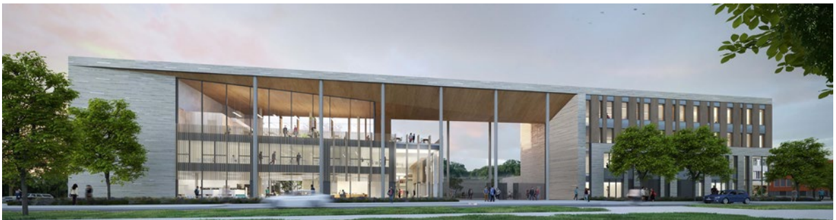
Façade Nord du Campus des Mines ParisTech
